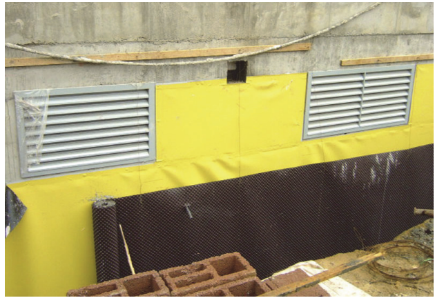
Fig. 4.71. Hidroizolimi vertikal
