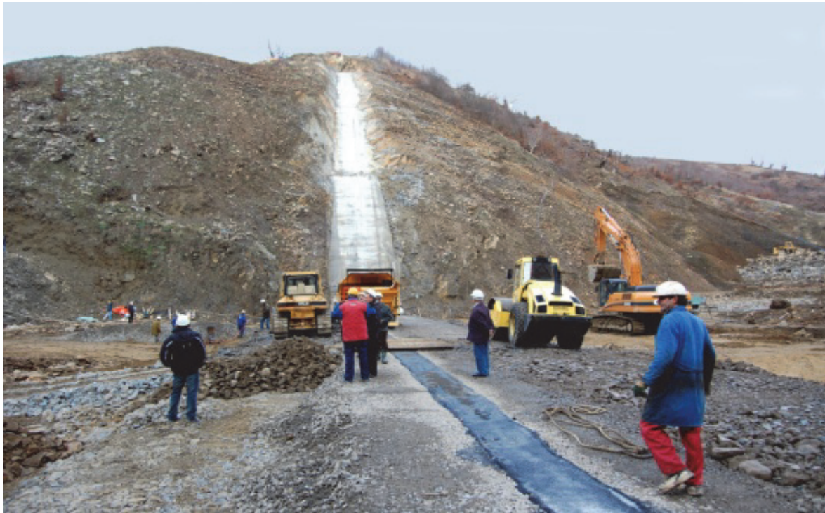
Fig. 5.2. Zbatimi i mekanizimit për punët me tokën gjatë ndërtimit të pendës Knezhevë
