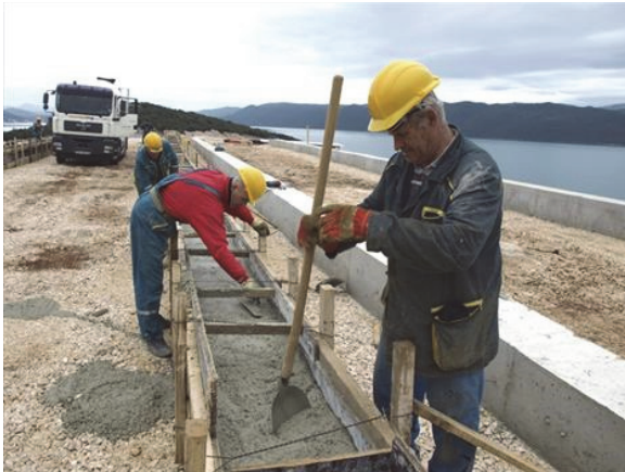
Fig. 4.55. Instalimi me dorë i betonit
