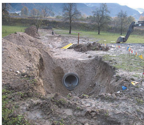
Fig. 4.25. Mbushja e gropës për rrjet kanalizimi
