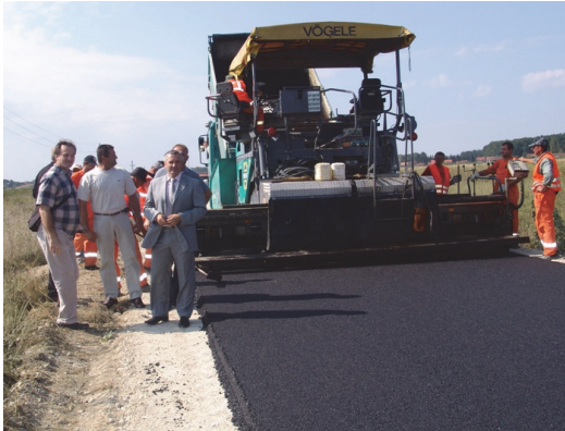
Fig. 4.73. Asfaltimi me finisher
