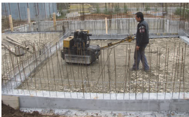
Fig. 4.31. a) Mbushja dhe ngjeshja e dyshemesë tek objekti pa podrum
