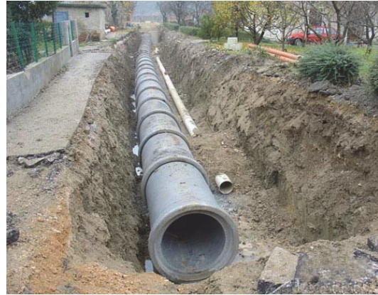
Fig. 4.11. Gërmimi i ngushtë për kanalizim
