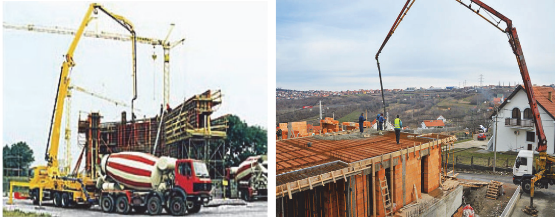
Fig. 5.30. Pompat për beton gjatë punës
