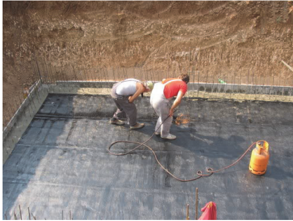
Fig. 4.70. Hidroizolimi horizontal
