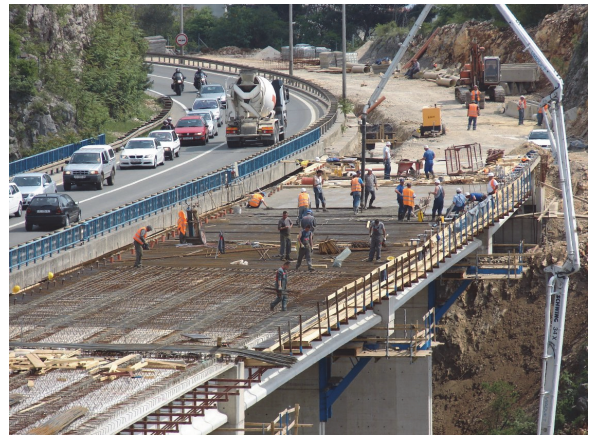
Fig. 4.56. Instalimi me makinë i betonit me pompë për beton
