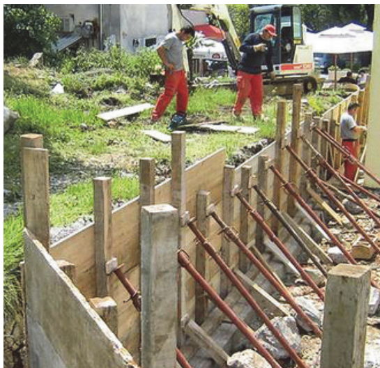
Fig. 4.36. Veshja njëanësore e murit mbështetës të betonit
