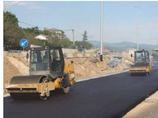
Fig. 4.74. Ngjeshja e asfaltit
