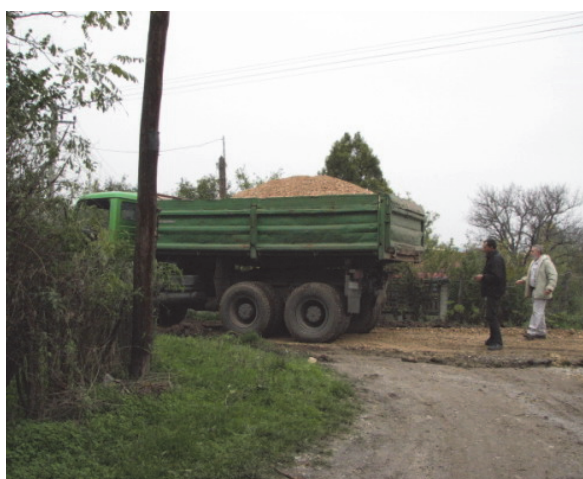
Fig. 4.24. Mbushja e rrugës ma zhavorr
