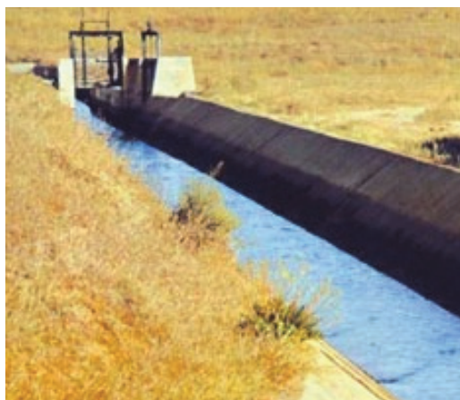
Fig. 3.7. Kanali për ujitje
